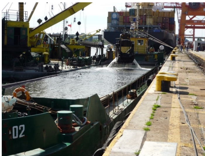
Rys. 3.5 Pogłębiarka chwytakowa wraz z szalandą pracująca przy nabrzeżu terminala kontenerowego BCT w Gdyni [103]
